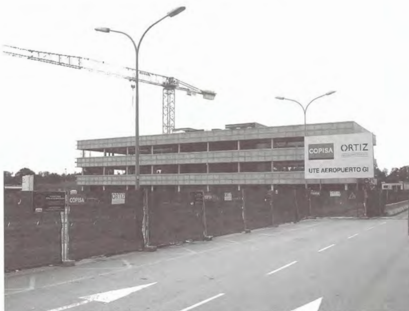
Obres de construcció d'un nou aparcament Foto: Moisès Jordi
