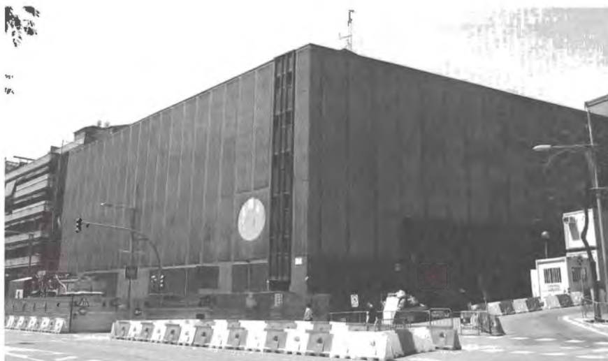
Obres de reparació de la subestació elèctrica de Maragall Foto: Àlex Tarroja
