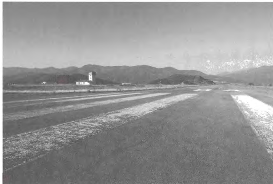
Actuals instal·lacions de l'aeròdrom de la Seu d'Urgell. Foto: ACN
