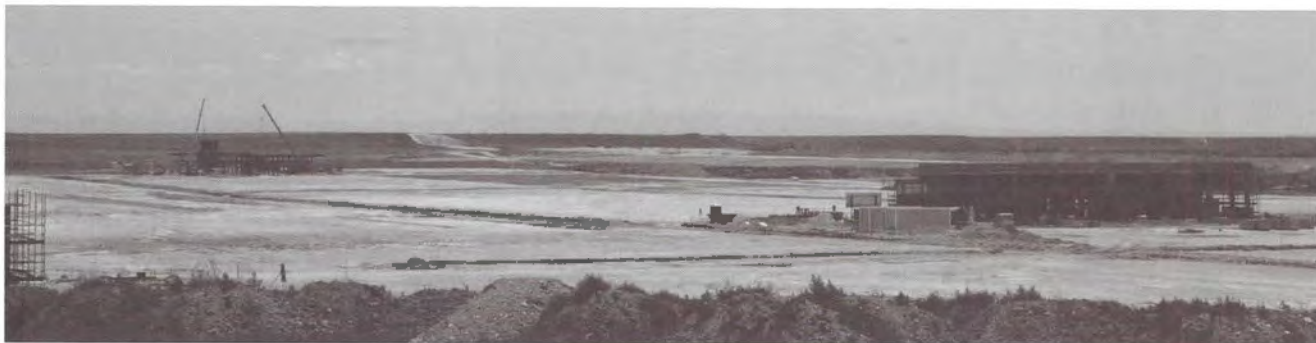
Vista general de les obres de l'aeroport. Foto: Àlex Tarroja
